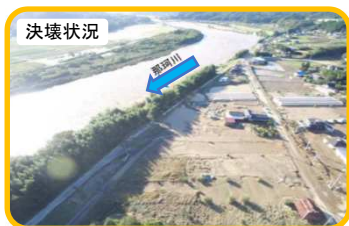
令和元年10月撮影(被災直後)
